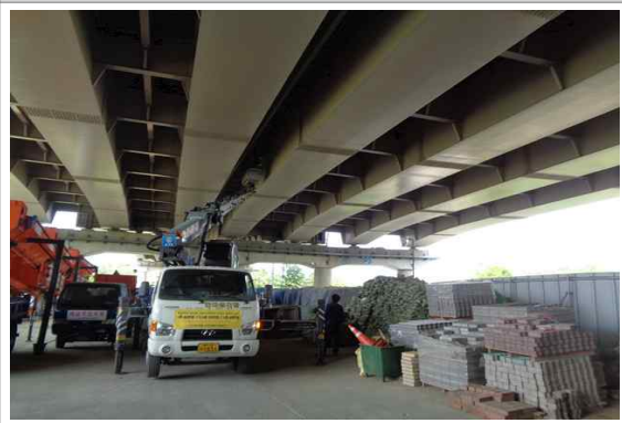
고소점검차를 활용한 근접조사
