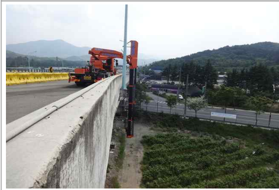
굴절차를 활용한 근접조사
